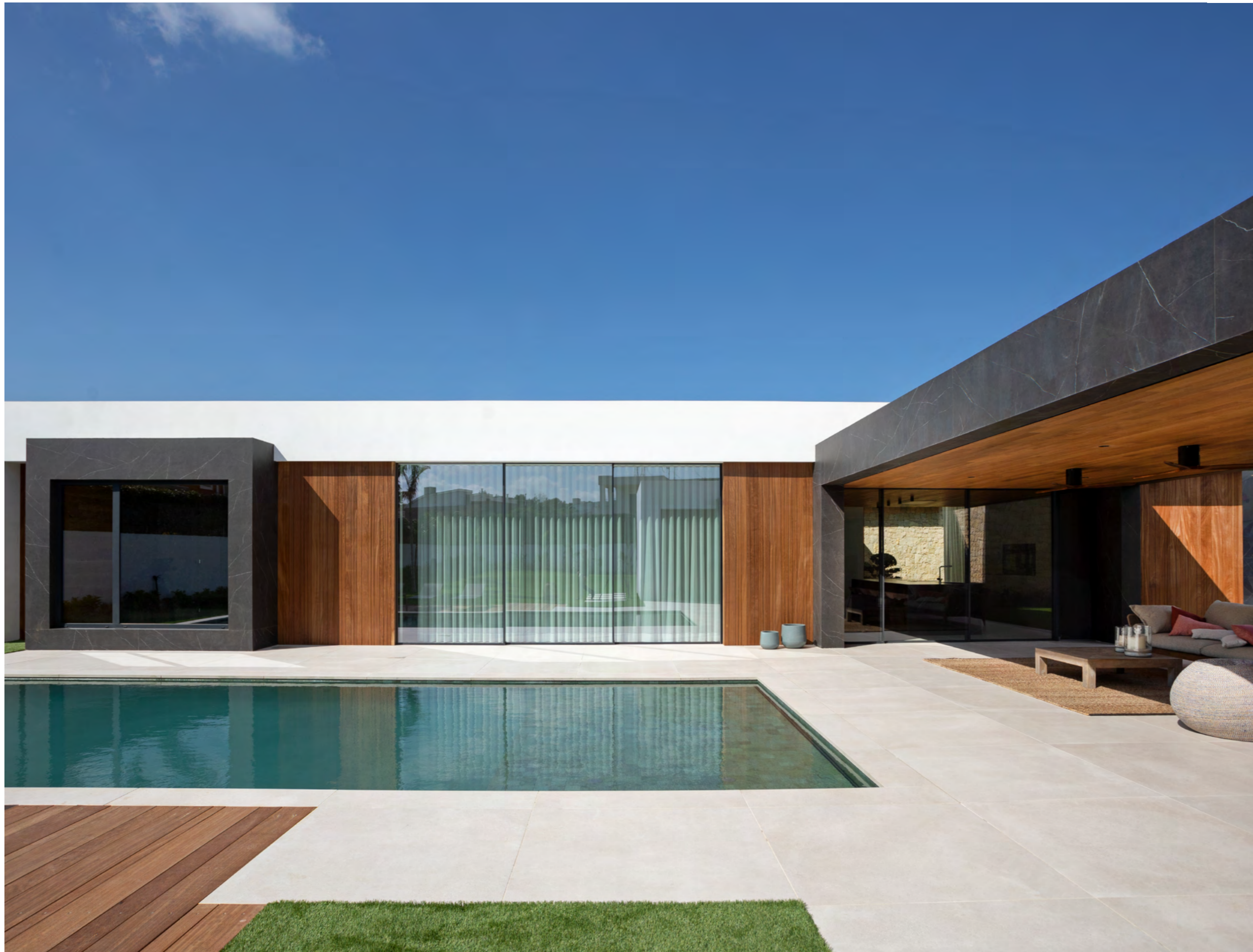
HOYO 7 Torre en Conill / España FOTOGRAFÍA: © DIEGO OPAZO
