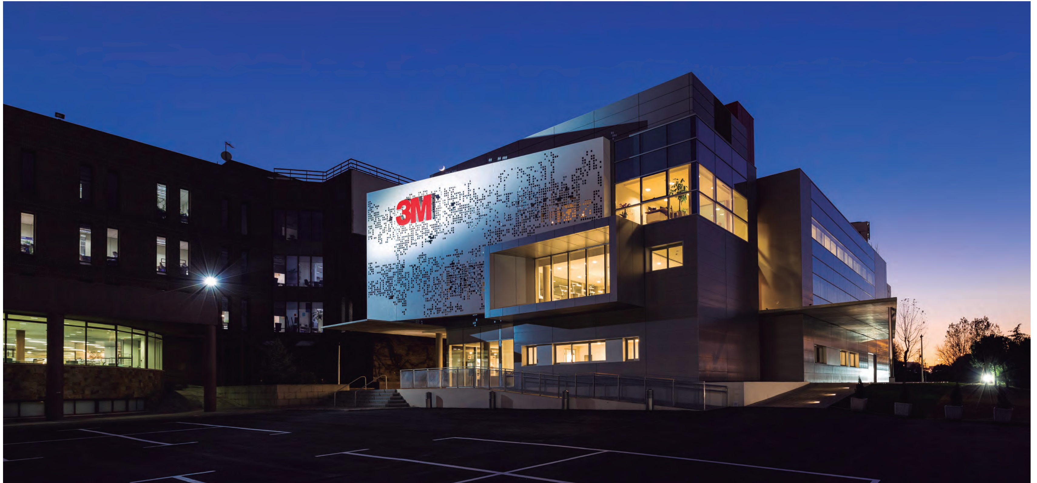
Touza Arquitectos diseñó para el Centro de innovación de 3M una fachada con 400 m 2 de Krion® Lux 1100 y contó con la asistencia de Butech en su construcción Touza Architects designed for the 3M Innovation Centre a façade with 400m 2 of Krion® Lux 1100 and was assisted by Butech in its construction.
