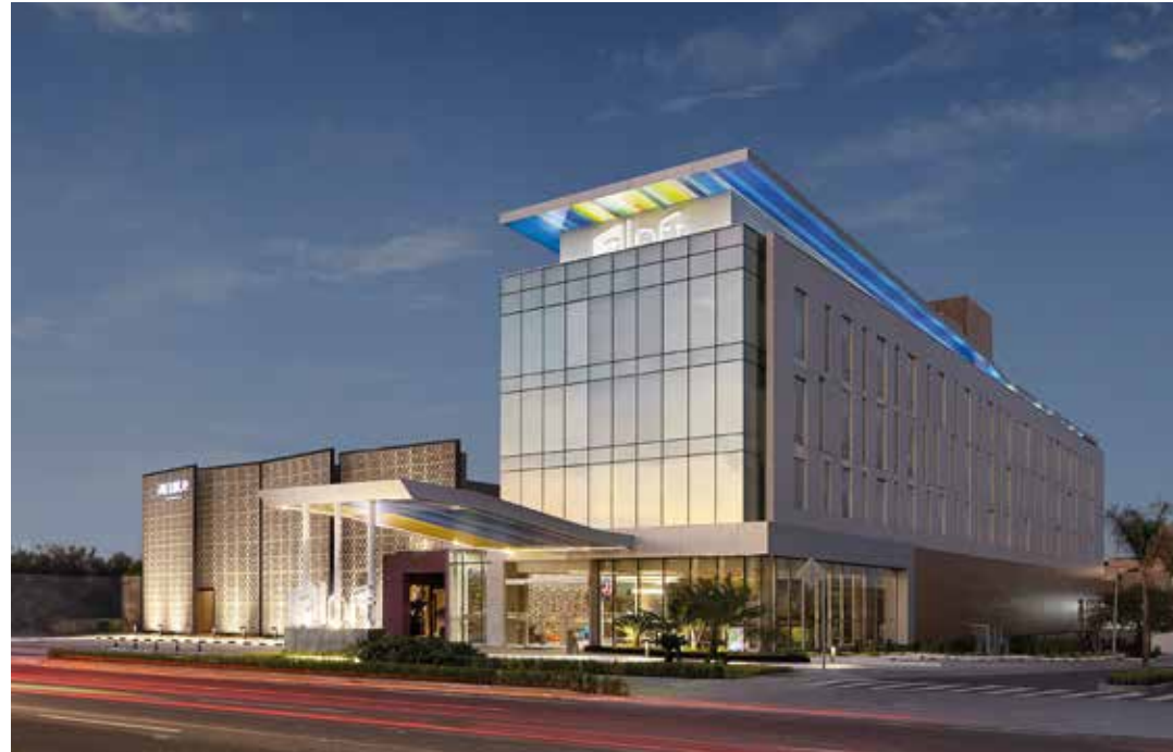
Hotel Loft Querétaro Querétaro, México Lemus Arquitectos Inmobiliaria ARAT SA DE CV
