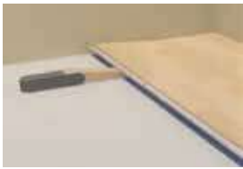
1. Tilt. Inclinar. Incliner.
