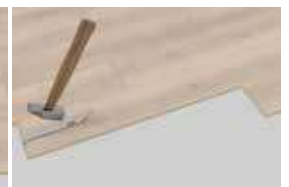
5. Hit the short of the plank until it fits together. Golpear el lado corto hasta encajar. Il faut frapper le petit côté jusqu'à ce qu'il s'enclenche en place.
